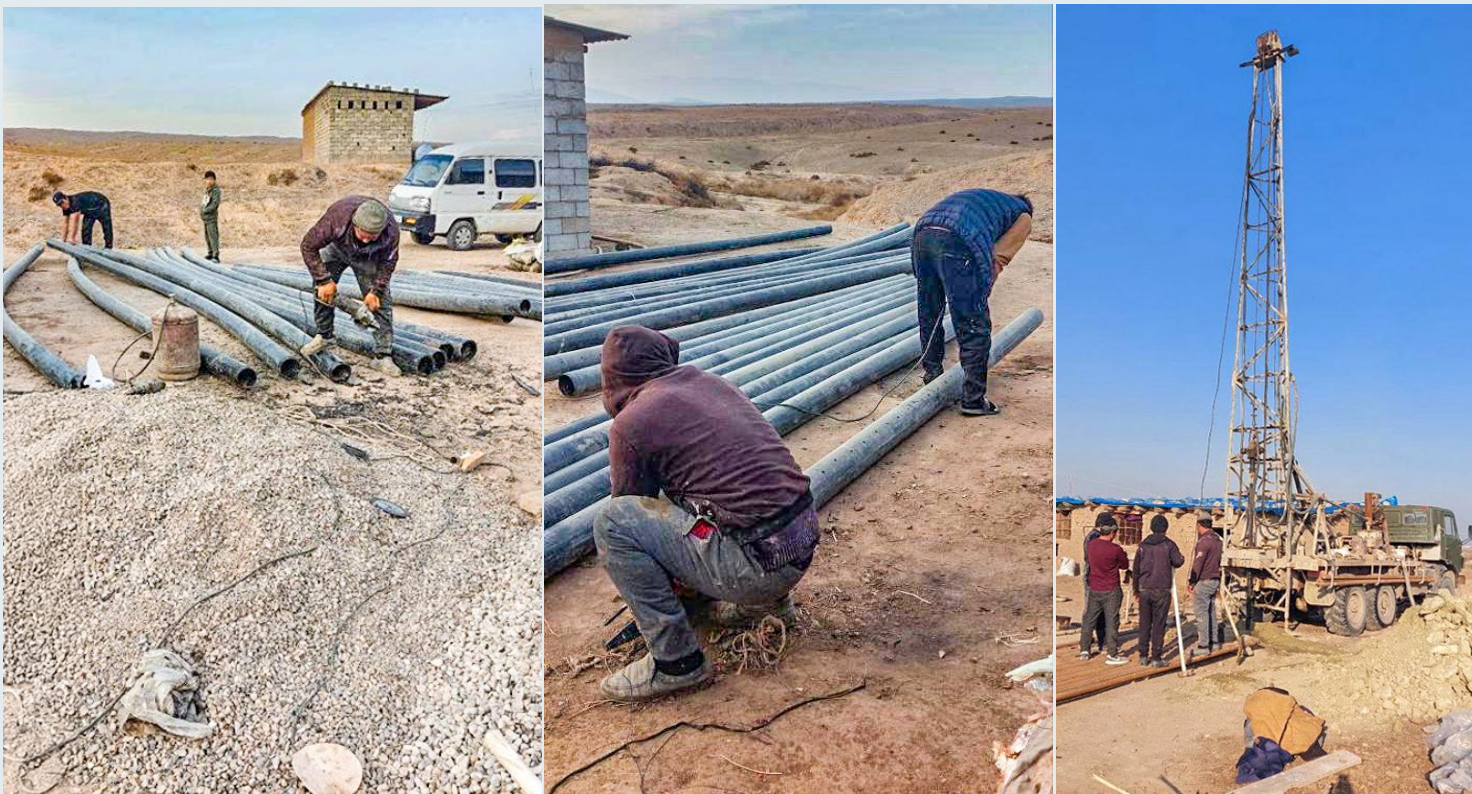
Die Arbeiten für den Dorfbrunnen sind in vollem Gange.
